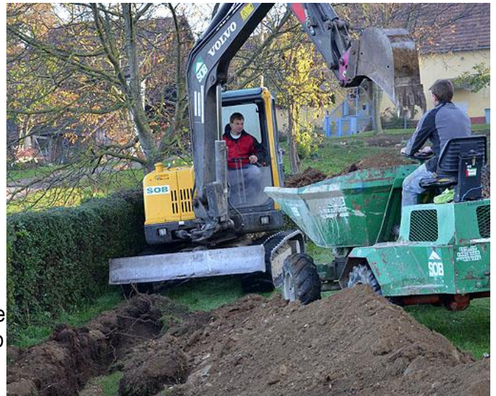
Da die durch Steinblöcke errichtete Mauer entlang der Westseite der Kirche durch Regenwasser unterspült wird, schlug das diözesane Bauamt eine Drainage des Kirchenplatzes vor. Die Grab- und Kanalarbeiten wurden von der Fa. SOB (Ulrich) am 23.10. durchgeführt.
